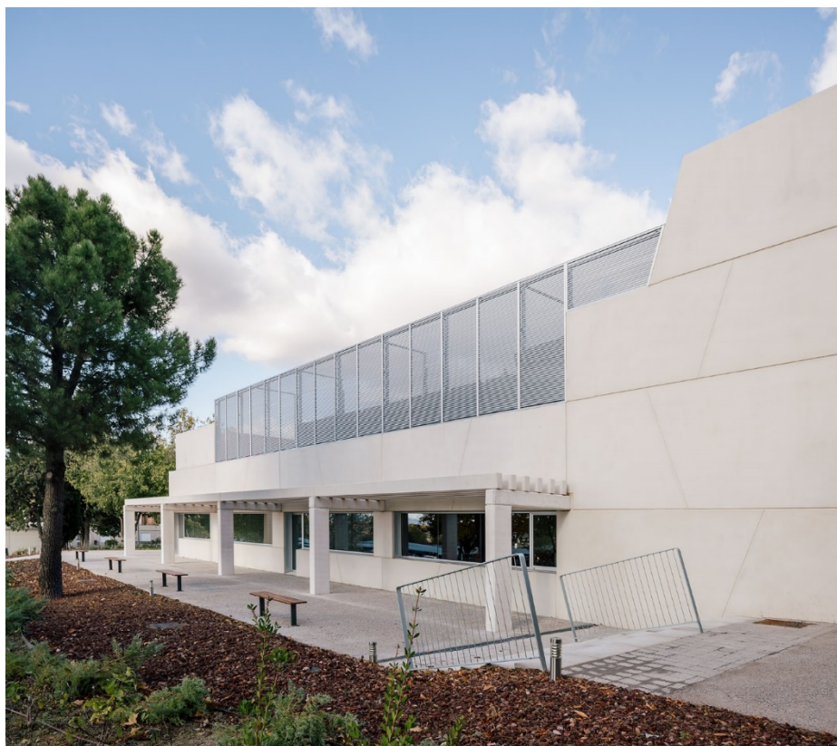
Zona exterior de las aulas 233, 234 y 235 (Edificio 53)
